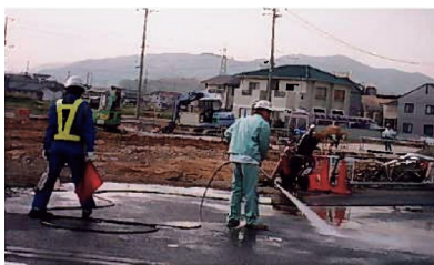
解体現場の防塵作業に威力発揮
