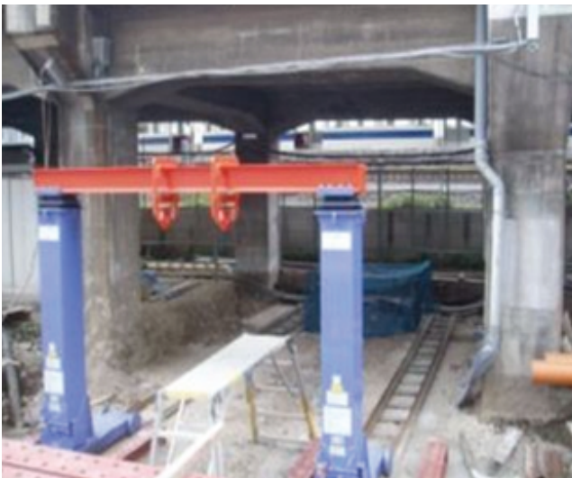
【TB-100】新高架架け替えの基礎工事
