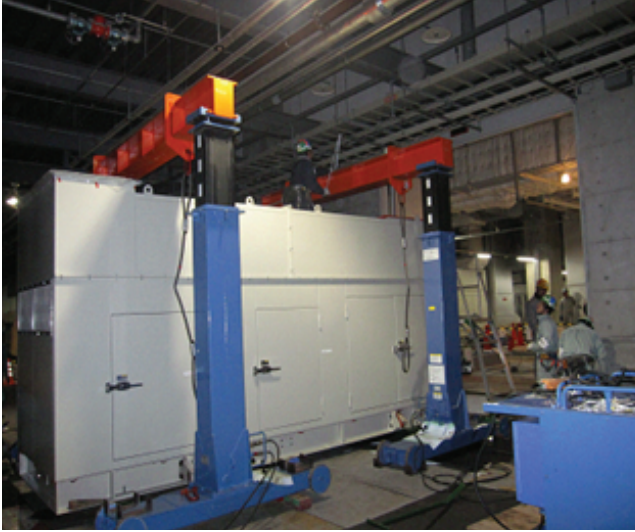
【TB-100×2台】緊急用発電機の地下搬入作業
