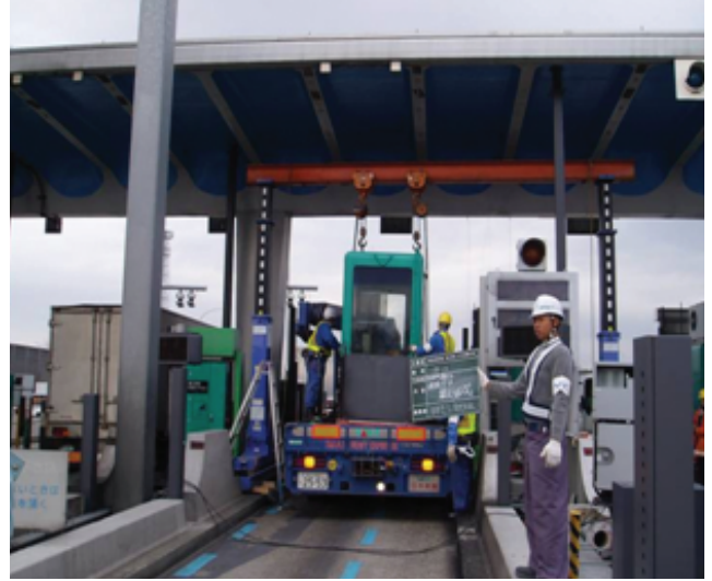
【TB-100】高速道路料金所の撤去作業
