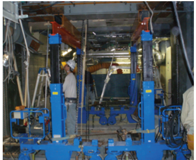
【TB-33×2台】デパート耐震補強のプレス設置作業
