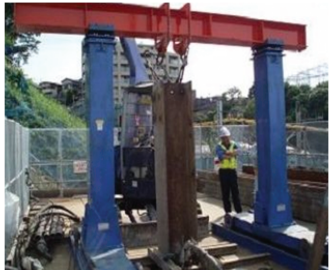
【TB-100】鉄道線路脇の基礎工事
