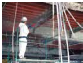
●ロックウールの除去
